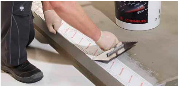
Укладка системной гидроизоляционной ленты ASO-Dichtband-2000 при помощи AQUAFIN-RS300 на балконный кромочный профиль.
